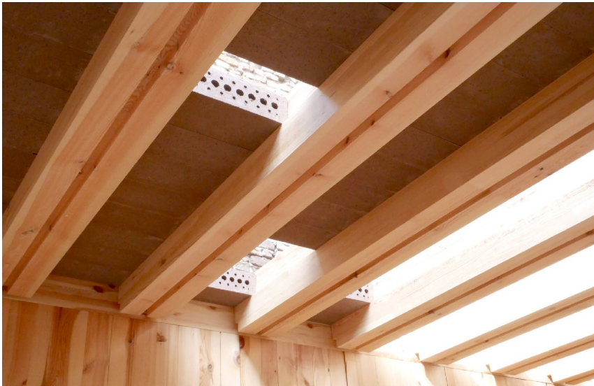
Abb. 04: Holz-Lehm-Hybriddecke mit tragenden Holzbalken und eingehängten Lehmformsteinen
