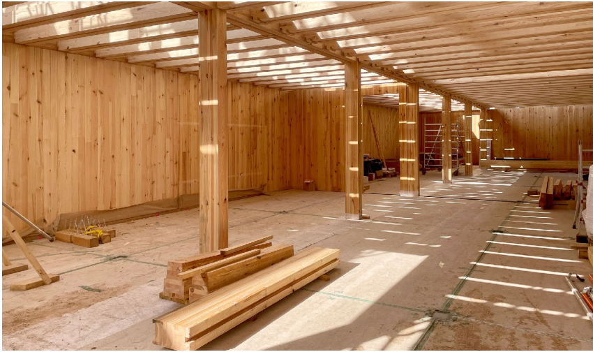
Abb. 05: Vorgefertigte Holz-Gebäudeabschlusswand mit sichtbaren Kiefernstielen im Innenbereich
