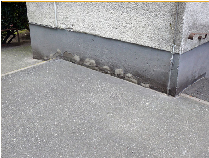
Abb. 01: Blick auf den Gebäudesockel
