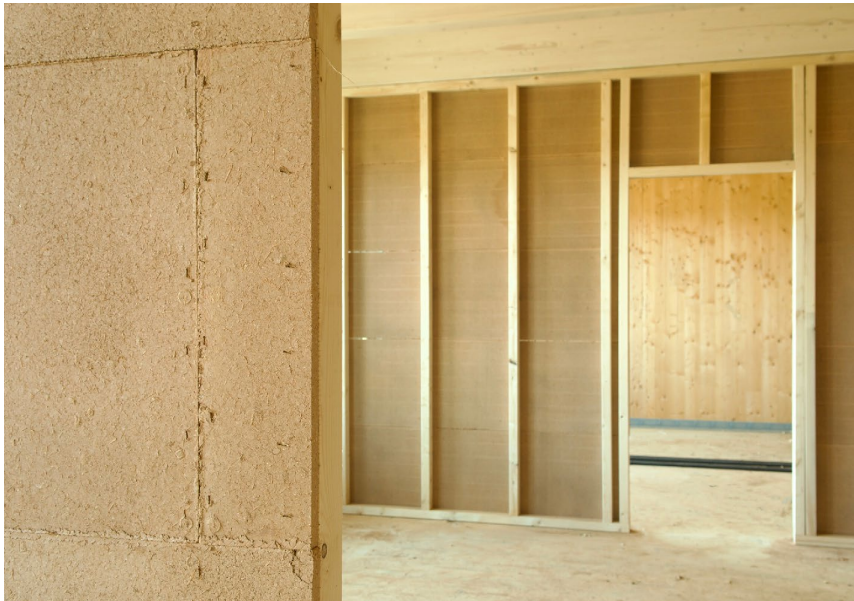
Abb. 02: Lehm-Trockenbau im Rohbau [ClayTec GmbH & Co. KG]
