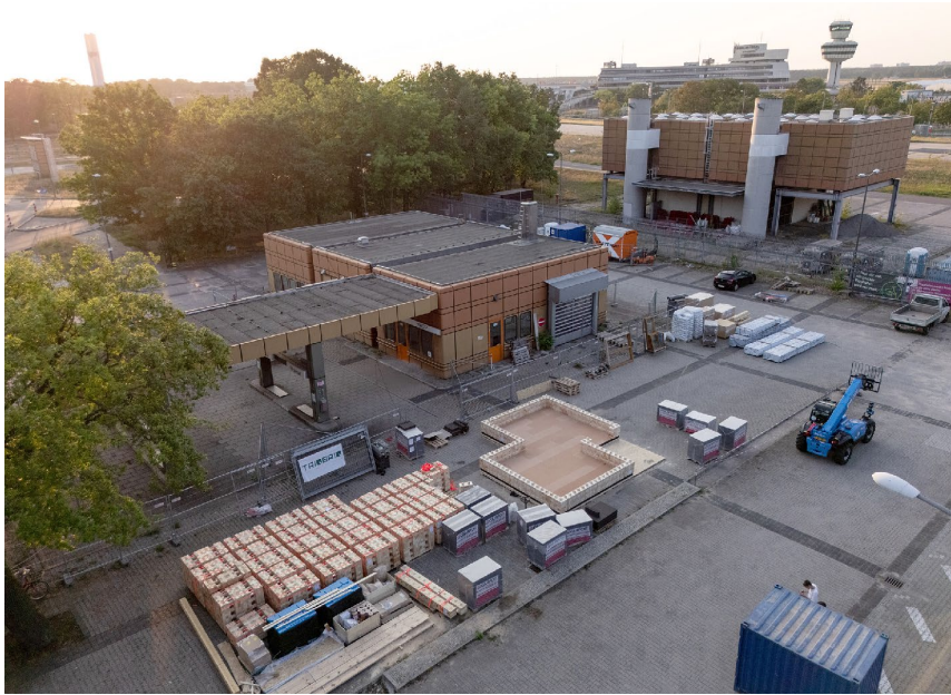
Abb. 04: Aufbau CRCLR HUT [Foto: TRIQBRIQ AG]
