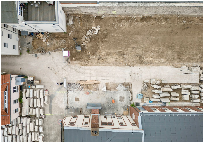
Abb. 01: Zuschnitt und Zwischenlagerung von Betonelementen aus dem Bestand zur Wiederverwendung als Re-Use-Fundamente.
