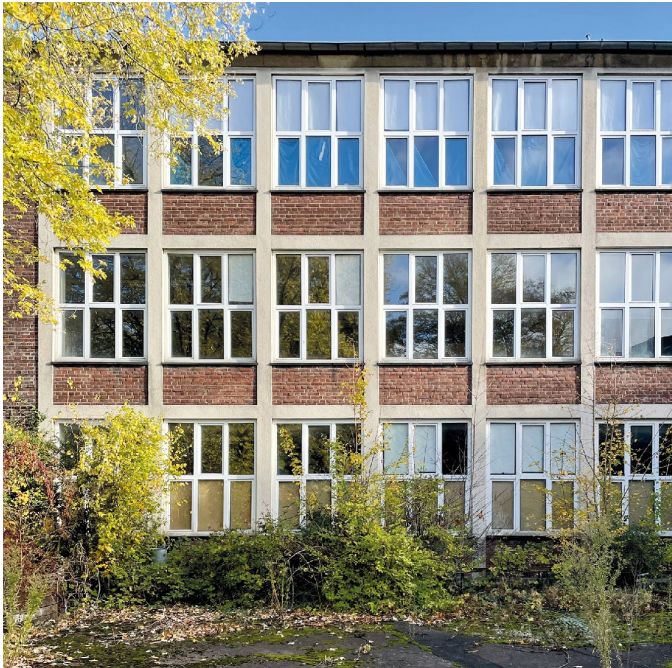
Abb. 02: Die ehemalige Schule in der Aachener Franzstraße [Foto: L. Hildebrand]
